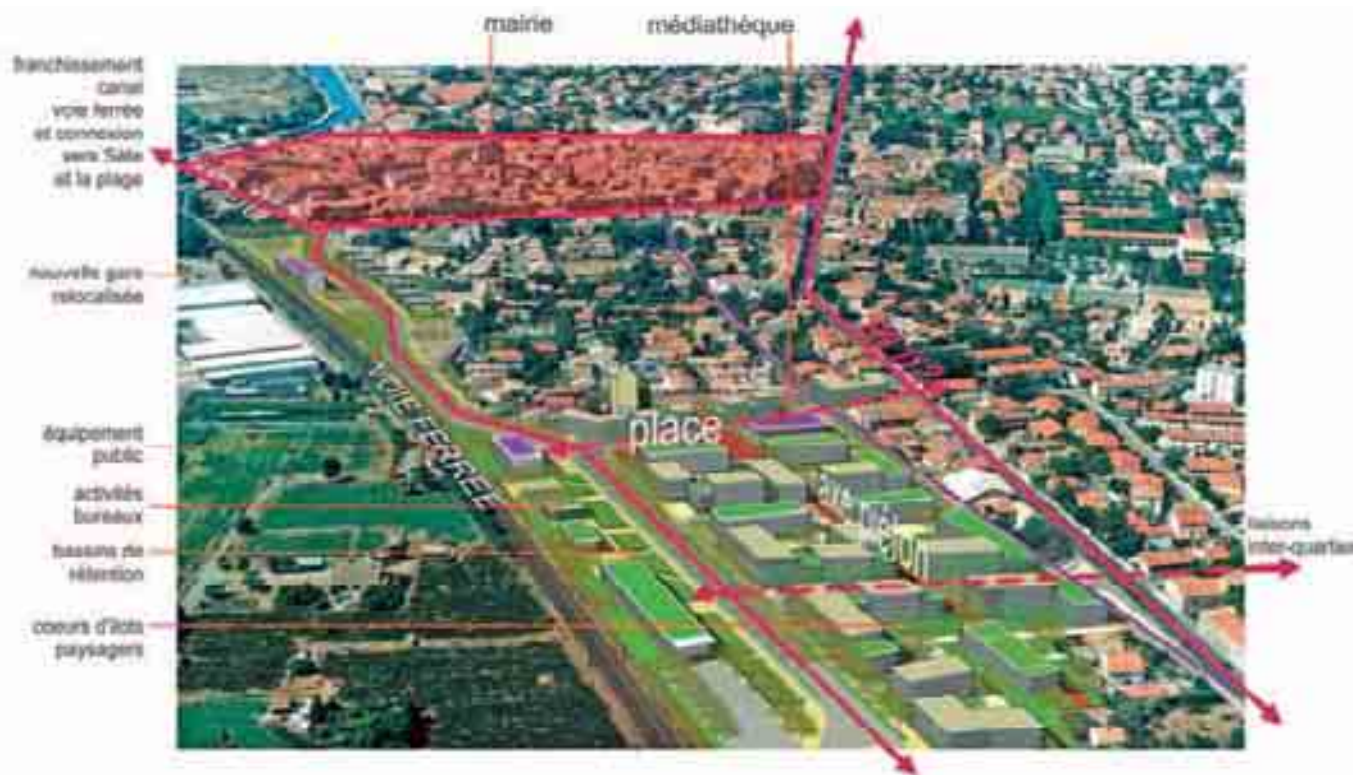
Le site de l'ancienne raffinerie de soufre va devenir un éco-quartier et s'insérer dans la ville.
